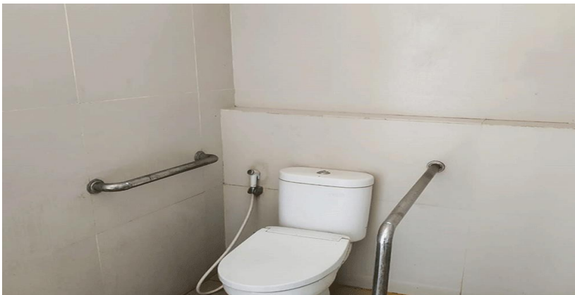
Toilet Disabilitas (sumber:google.com)
